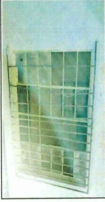
Foto 6: Cambio de balcones.
